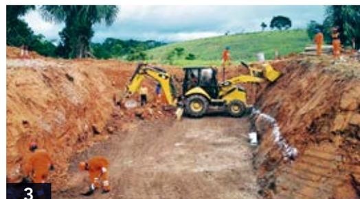
**1.** Trabajos de instalaciones de campamentos km 49+200 - Puerto Súngaro Dv. San Alejandro. **2.** Trabajo de Movimiento de Tierras - Corte y eliminación de material suelto. **3.** Trabajos de excavación para la alcantarilla AMC - km 59+842.
