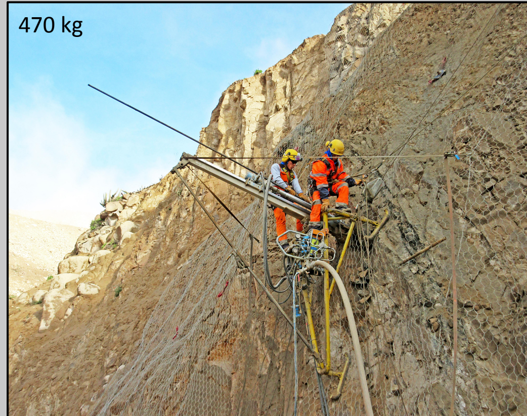
Perforación en altura, aligerada
