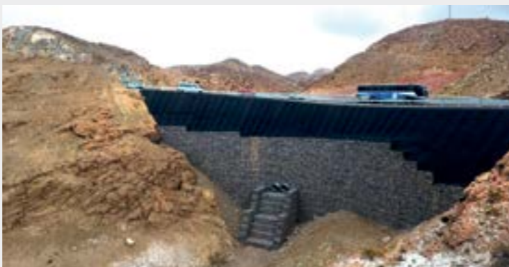
Construcción del Muro Terramesh® y obras Conexas - Tercera variante Vía AR 115, Arequipa.
