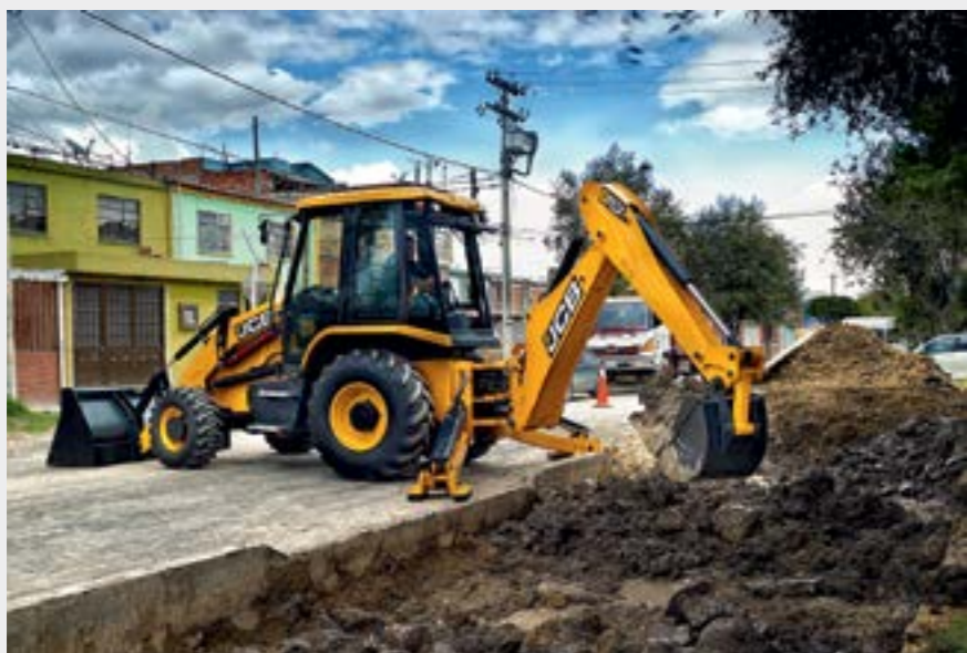
Retroexcavadora 3CX JCB.
