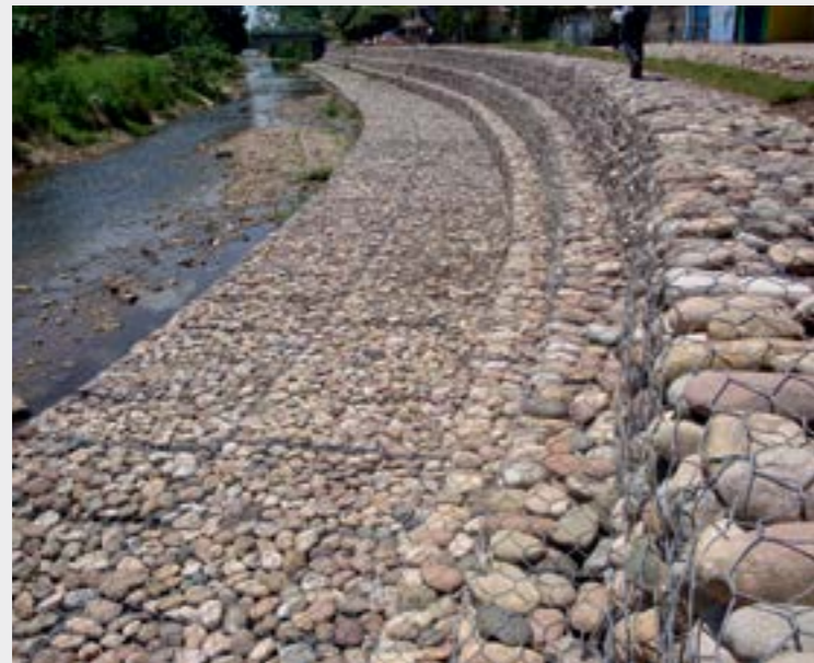
Defensa Ribereña con Gaviones y Colchones Reno® - Río Negro, Aguaytia.
