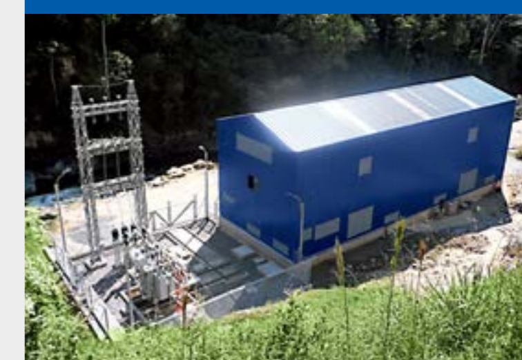
Casa de Máquinas de la Central Hidroeléctrica El Carmen
