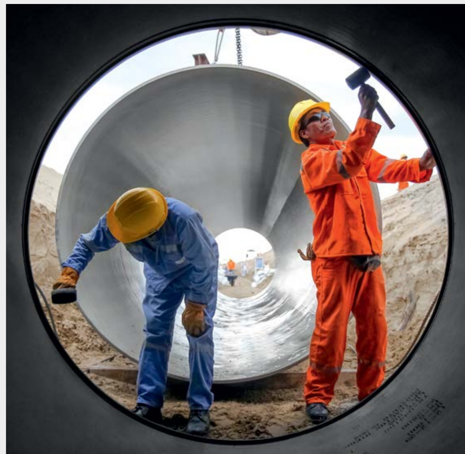
Obra con tuberías de agua, Lima, Perú
