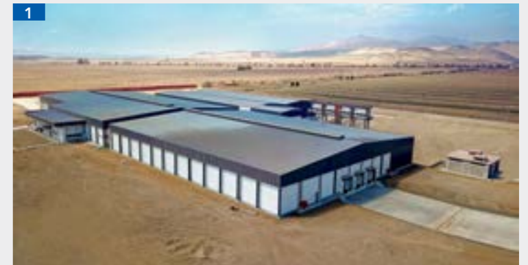
1. Planta industrial de la empresa Hortifrutal ubicada en Trujillo; La Libertad, construida con materiales CALAMINON. 2. Colegio Emblemático Juan Guerrero Quimper, ubicado en Villa María del Triunfo, Lima, construido con materiales CALAMINON.
