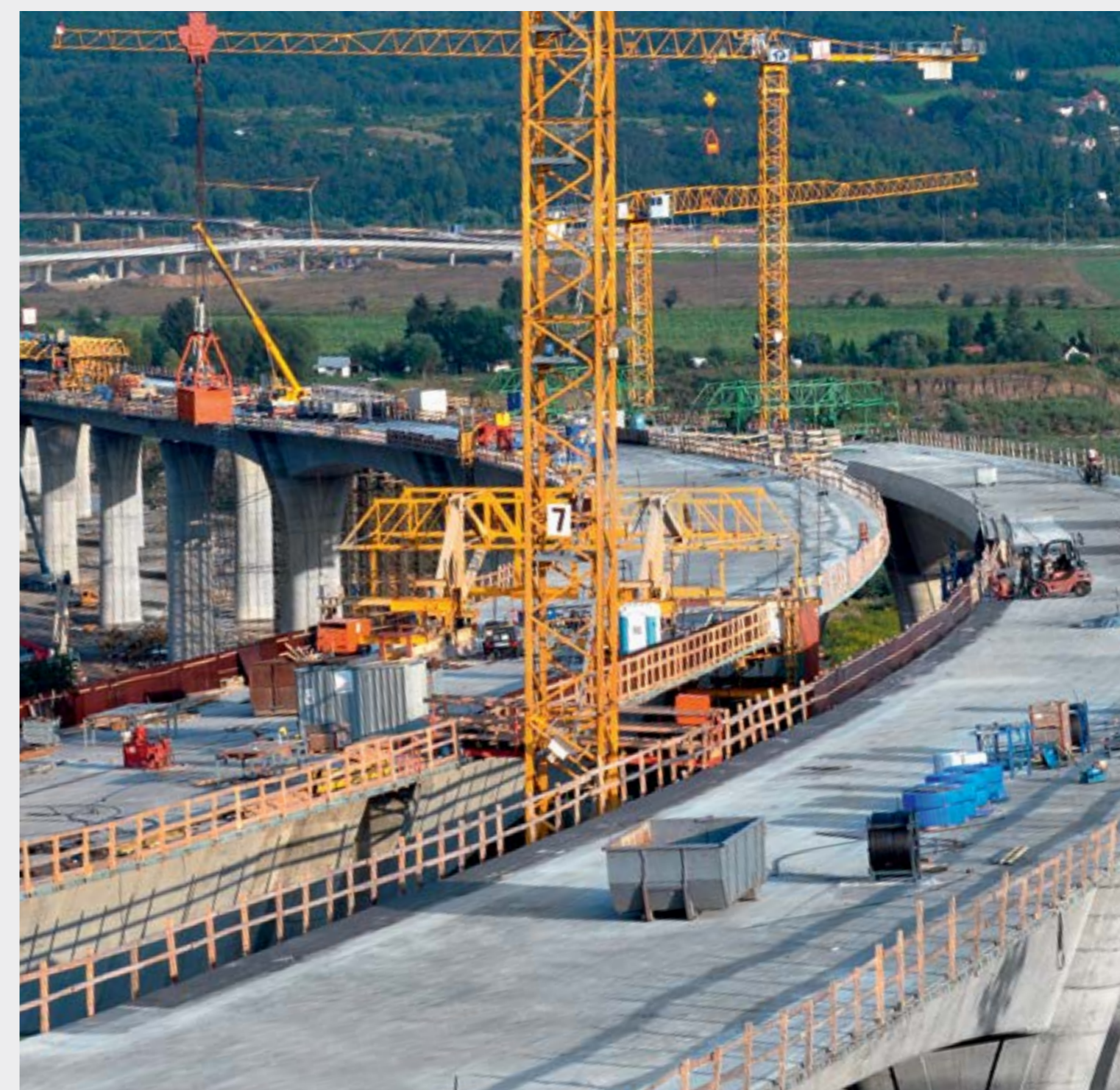
Construcción de puente, República Checa
