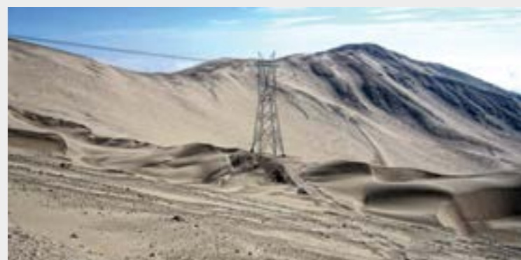
Diseño y Supervisión de la Ingeniería, Suministro y Construcción de la Línea de Transmisión a 500 kV Mantaro – Marcona – Socabaya – Montalvo y Subestaciones asociadas.
