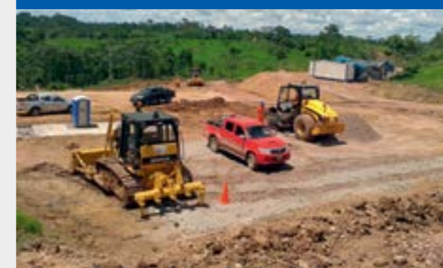
Trabajos de instalaciones de campamentos Km. 49+200- Puerto Súngaro Dv. San Alejandro.
