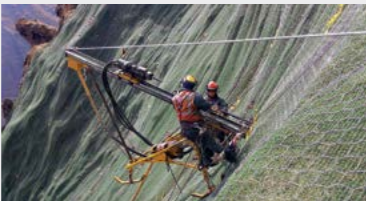
Instalación de Sistema Mac.Ro®.
